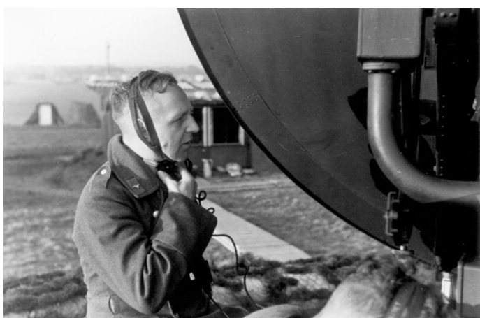
Radar Würzburg – niemiecki radar naziemny licencja: CC BY-SA 3.0
