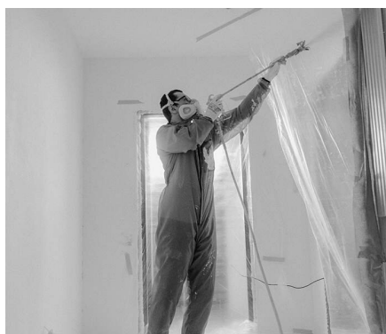
Malowanie natryskowe powierzchni przy użyciu pistoletu malarskiego
