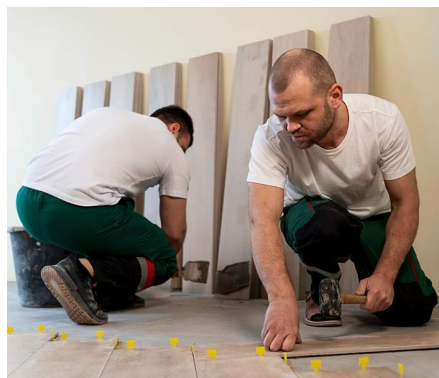
Montaż paneli podłogowych
