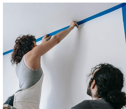
Przygotowywanie pomieszczenia do malowania – naklejanie taśmy malarskiej w celu wyznaczenia granicy kolorów ścian i sufitu
