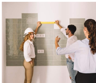
Wyznaczanie/sprawdzanie poziomu za pomocą poziomnicy (libelli) podczas wykonywania prac glazurniczych (układania płytek ceramicznych na ścianie)
