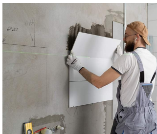
Układanie/przyklejanie płytek ceramicznych na ścianie łazienki
