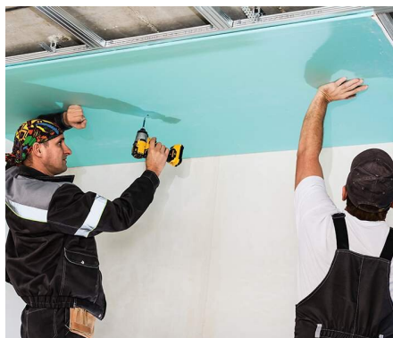
Montaż sufitów podwieszanych (montaż płyty gipsowo-kartonowej)
