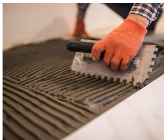
Nakładanie kleju/zaprawy klejowej na podłoże pacą zębatą
