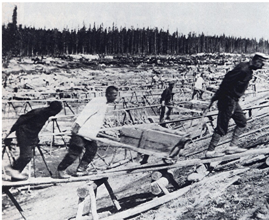
Budowa Kanału Białomorskiego, 1932. Kanał łączył Morze Bałtyckie i Morze Białe. Był efektem pracy 170 tysięcy więźniów w latach 1930-1933.
