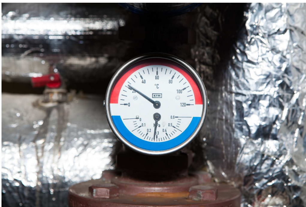
Termometr bimetaliczny, stosowany w systemach grzewczych i wodociągowych
