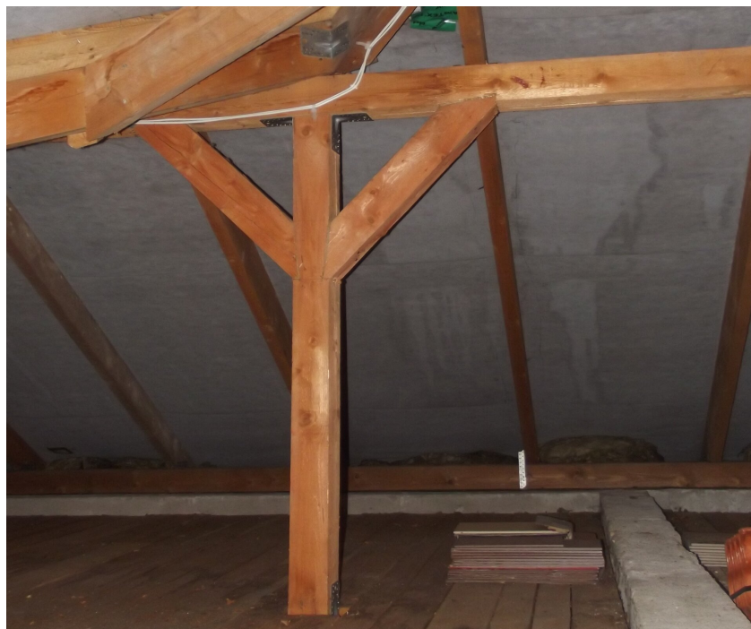
Rys. a. Połączone ze sobą drewniane elementy konstrukcji dachowej.
