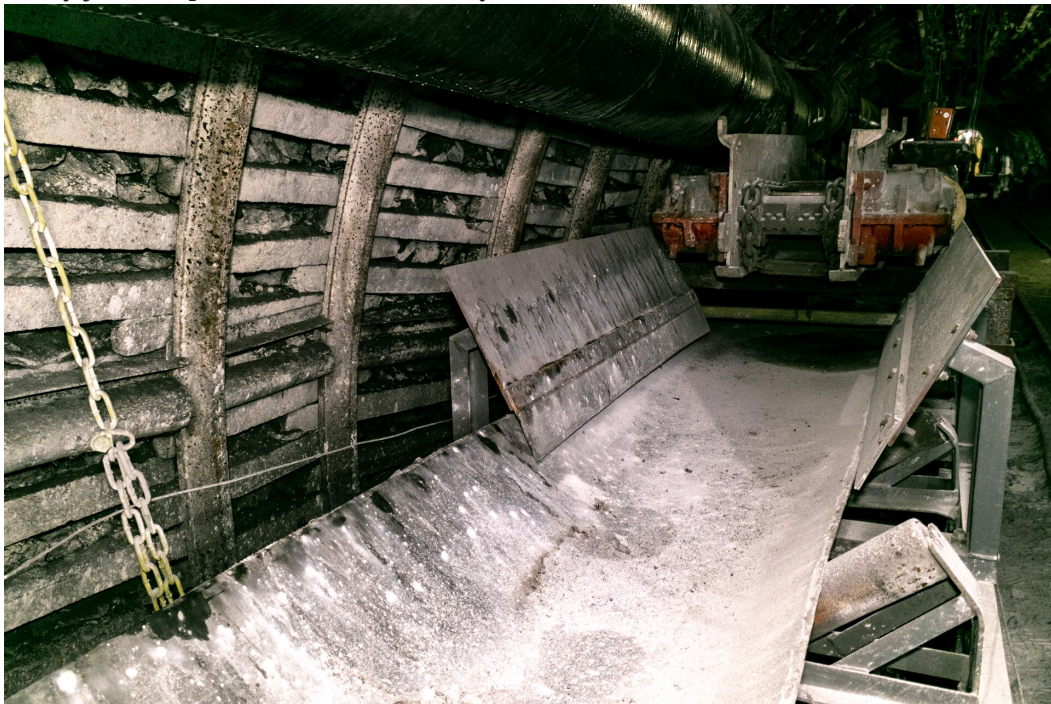
Miejsce przesypu urobku
