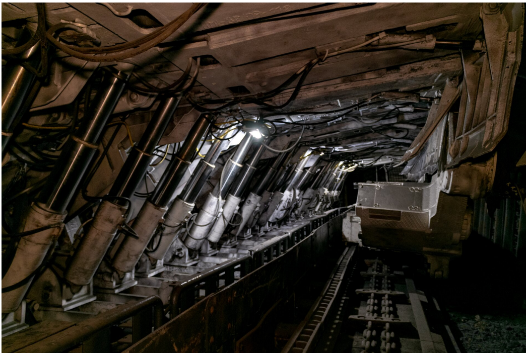
Przenośnik ścianowy zamontowany w obodowie zmechanizowanej
