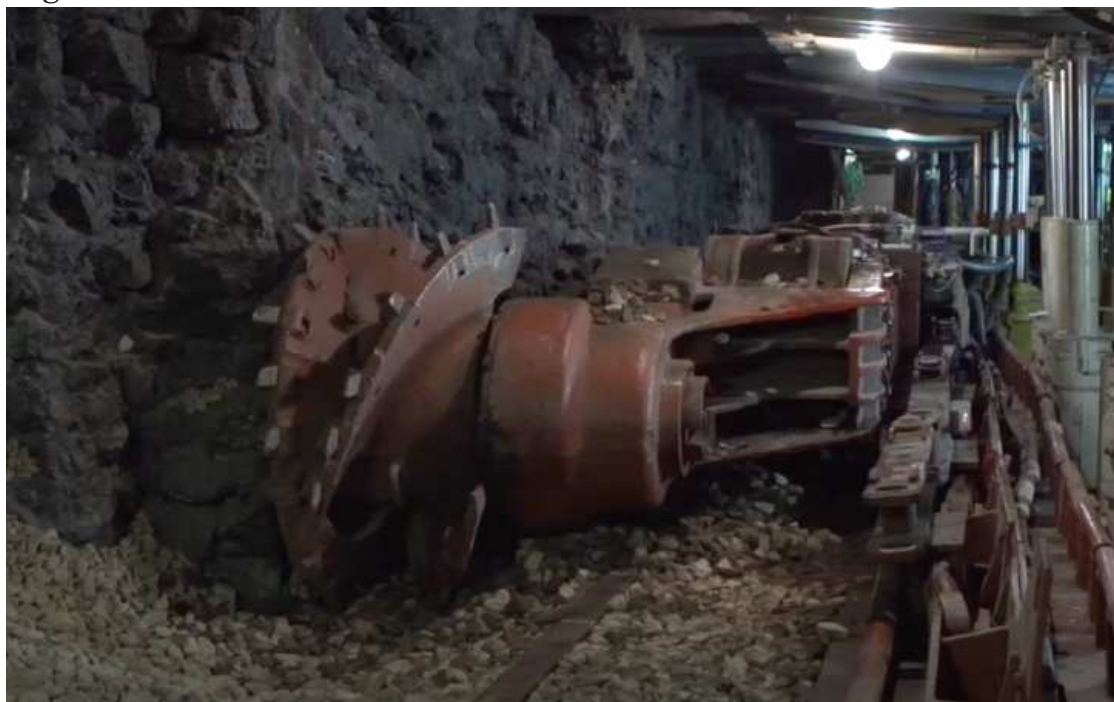
Organ urabiający kombajnu ścianowego
