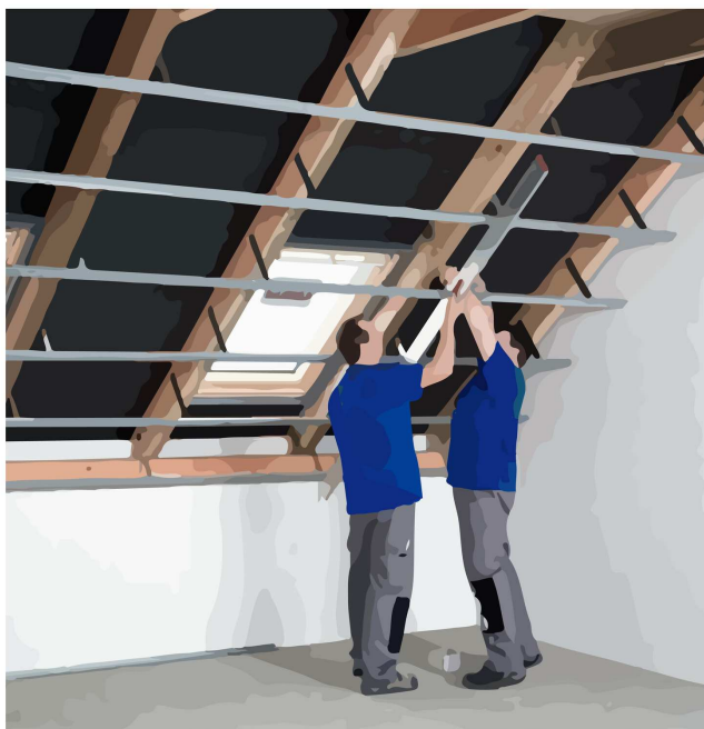
Rys. 61. Sprawdzenie płaszczyzny wyznaczonej przez ruszt
