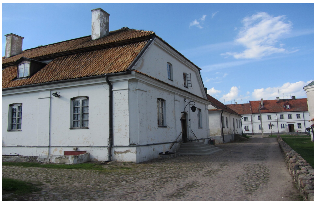
Klasyczne kamienice Tykocina w okolicy Wielkiej Synagogi
