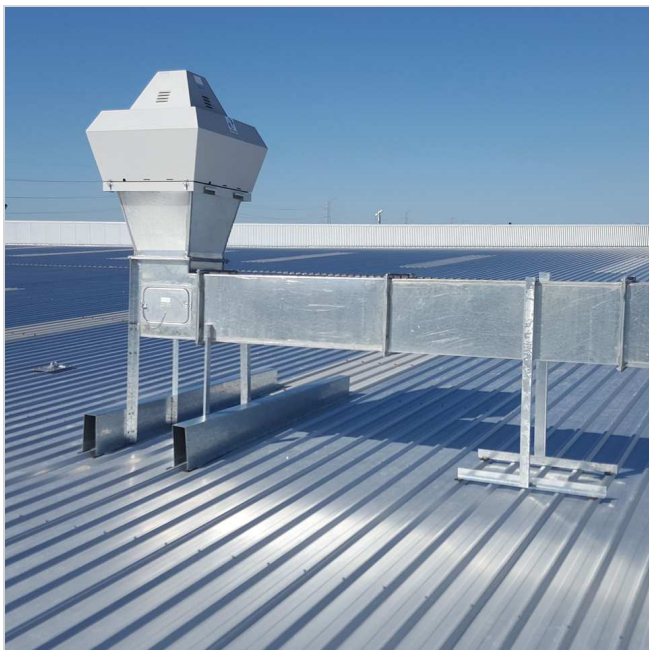
Budowa instalacji klimatyzacyjnej typu kompakt (monoblock)
