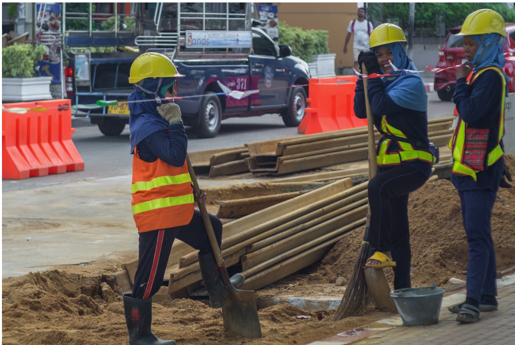
Kobiety w Tajlandii pracujące podczas remontu drogi
