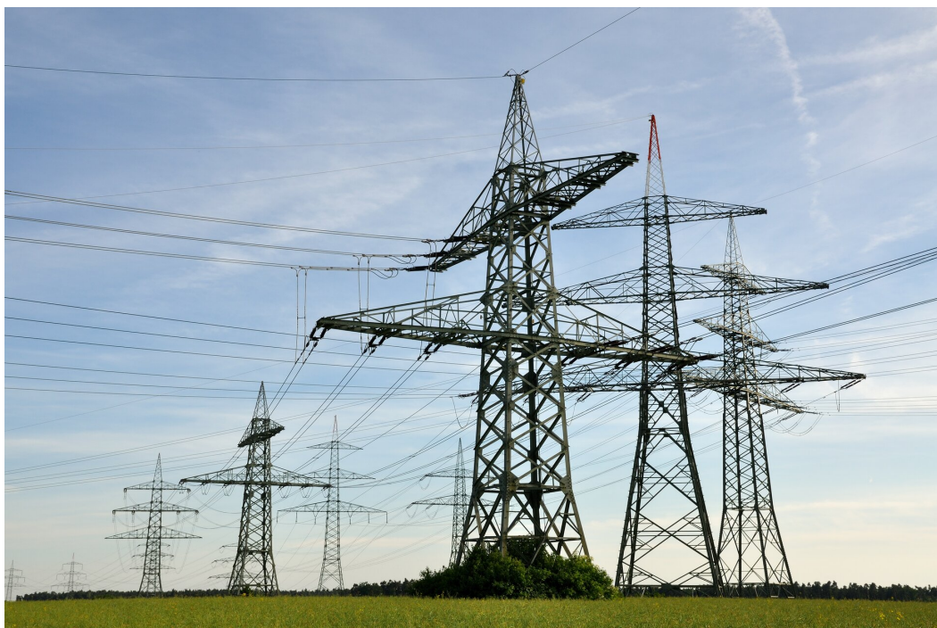
Sieć wysokiego napięcia
