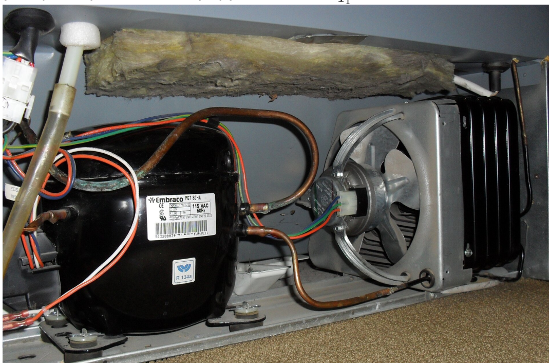
Fot. 1. Klimatyzator od środka. Czarna bańka to zbiornik z gazem, który po schłodzeniu przepuszczany jest przez radiator z wiatrakiem po prawej stronie
