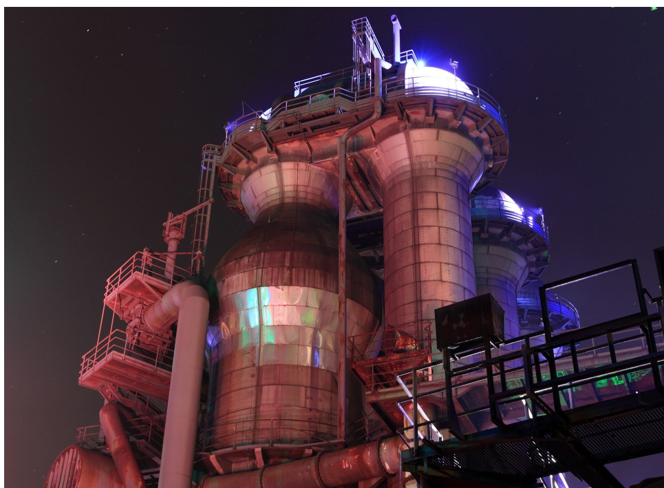
Wielki Piec w Dąbrowie Górniczej ma aż 41 m wysokości.
