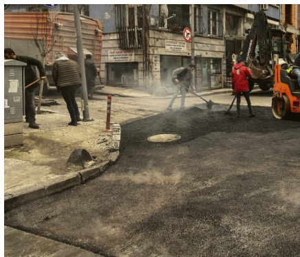
Układanie nawierzchni asfaltowej
