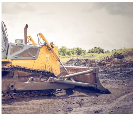
Wyrównywanie poziomu drogi przy użyciu spychacza
