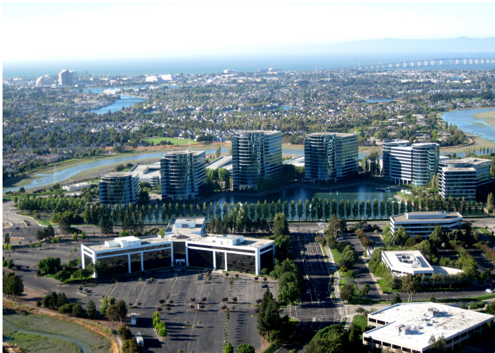
Główna siedziba firmy Oracle w Redwood City w stanie Kalifornia (USA)
