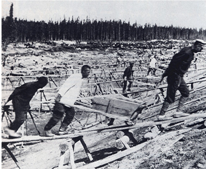
Więźniowie przy budowie Kanału Białomorsko-Bałtyckiego, 1932
