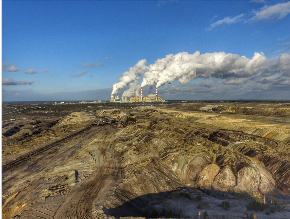
Elektrownia Bełchatów zlokalizowana w pobliżu kopalni węgla brunatnego
