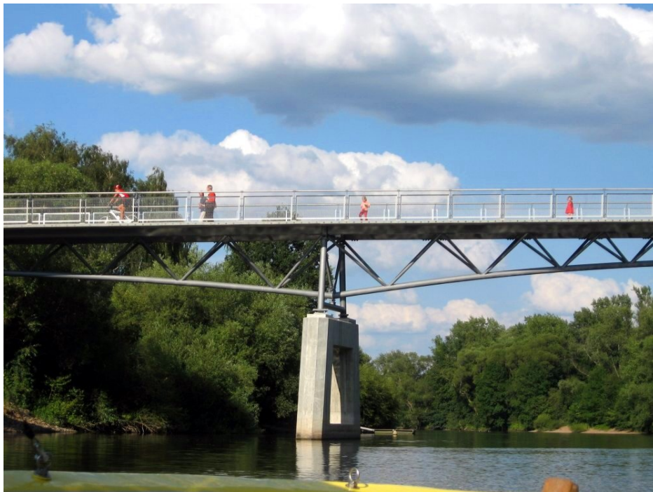
Most Gärtnerplatz w miejscowości Kassel w Niemczech zbudowany w 2007 r.
