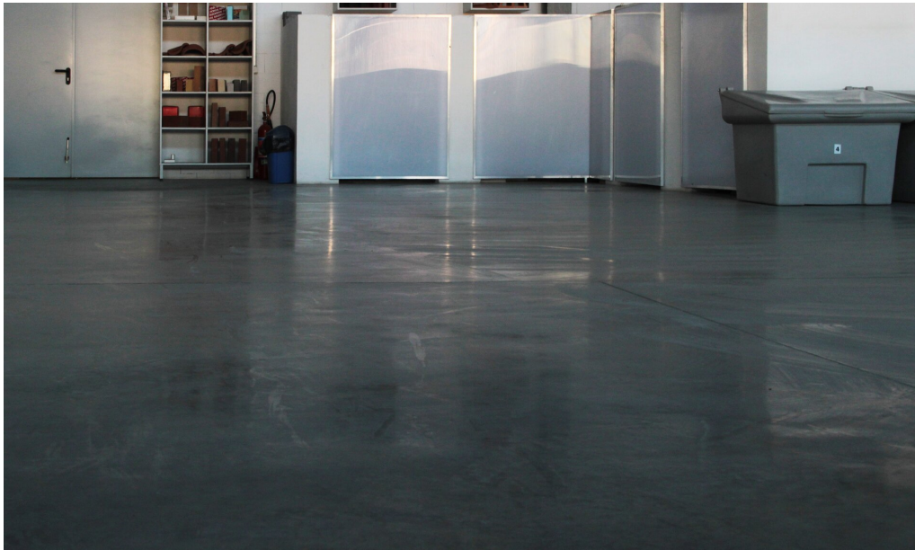
Posadzka przemysłowa wykonana z fibrobetonu
