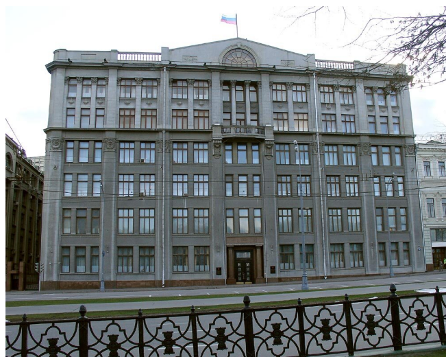
Główny budynek KC byłej KPZS na Starym Placu 4, obecnie siedziba Administracji Prezydenta Rosji
