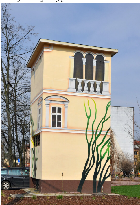
Rys. 5. Wieża transformatorowa w Grodzisku Mazowieckim.
