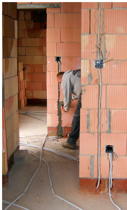
Rys. 5. Przykład wykonania domowej instalacji elektrycznej
