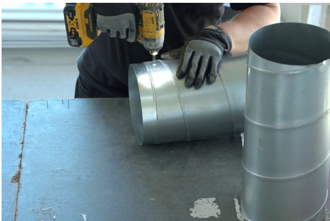
Zdj. 1. Łączenie rur typu spiro za pomocą nypla i wkrętów samogwintujących
