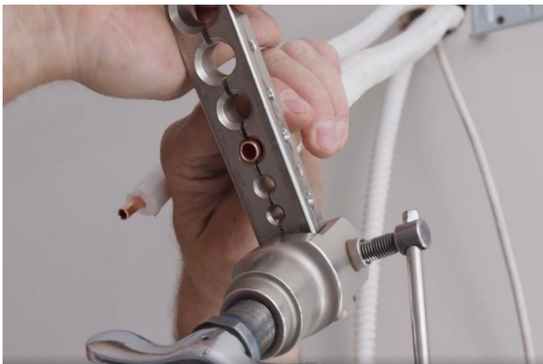
Zdj. 4. Wykonanie połączeń kielichowych za pomocą kielicharki
