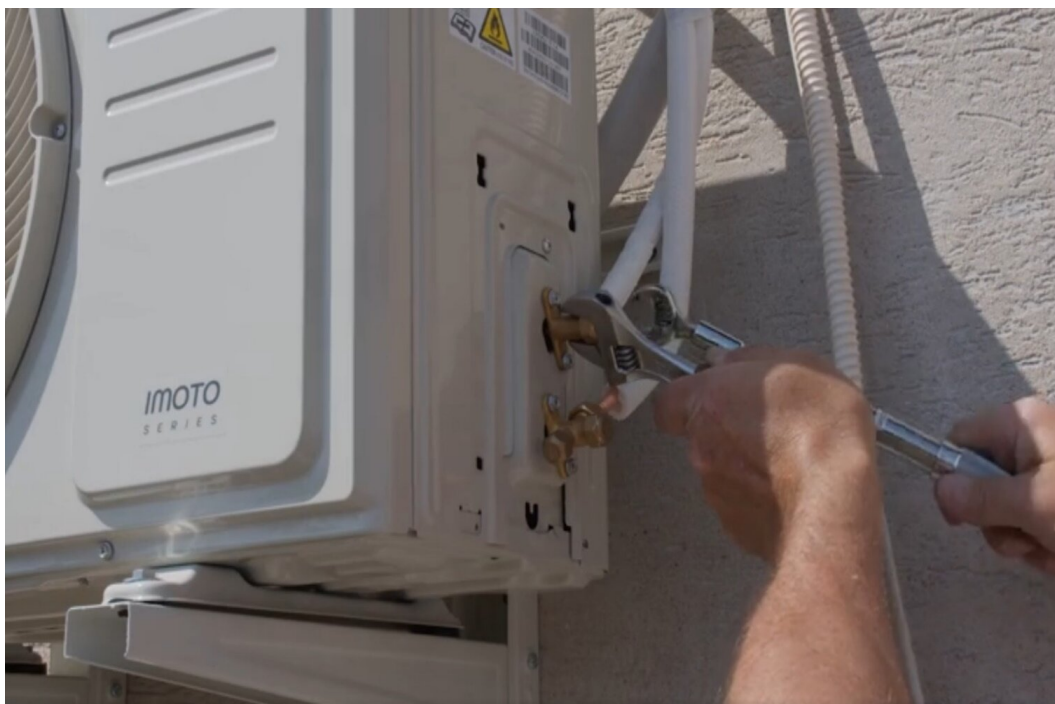
Zdj. 6. Podłączenie rur chłodniczych do jednostki zewnętrznej klimatyzatora
