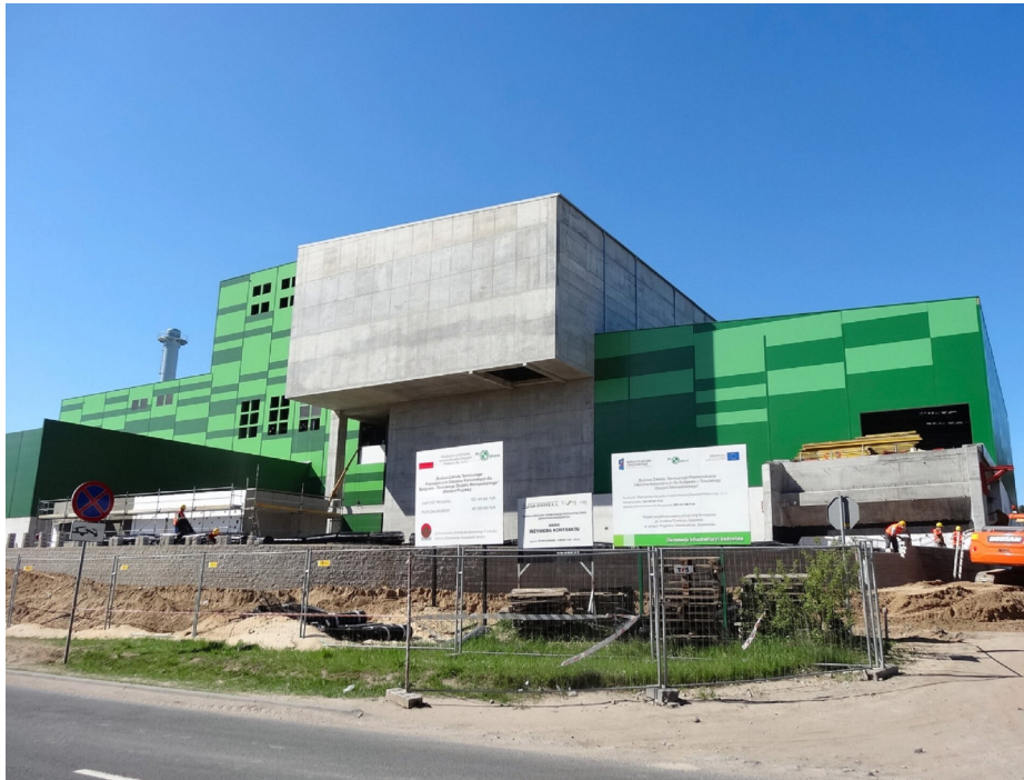
Oddany do użytku w 2015 r. Zakład Termicznego Przekształcania Odpadów Komunalnych w Bydgoszczy Źródło: Pit1233, dostępny w internecie: www.wikipedia.org , licencja: CC 0 1.0.
