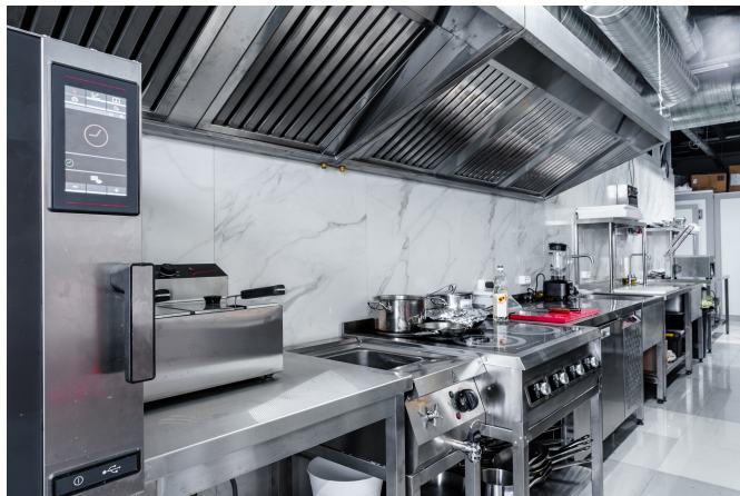
Przygotowanie miejsca pracy
