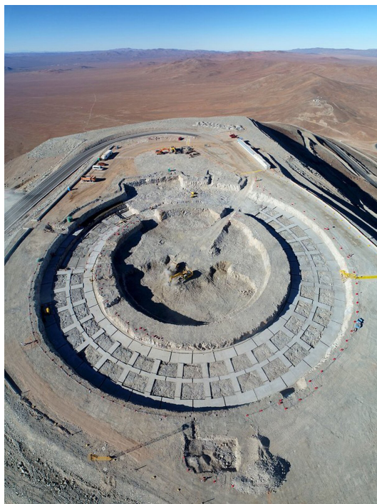
Rys. 1. Zdjęcie przedstawia fundamenty pod budowę ELT na szczycie góry Cerro Armazones .
