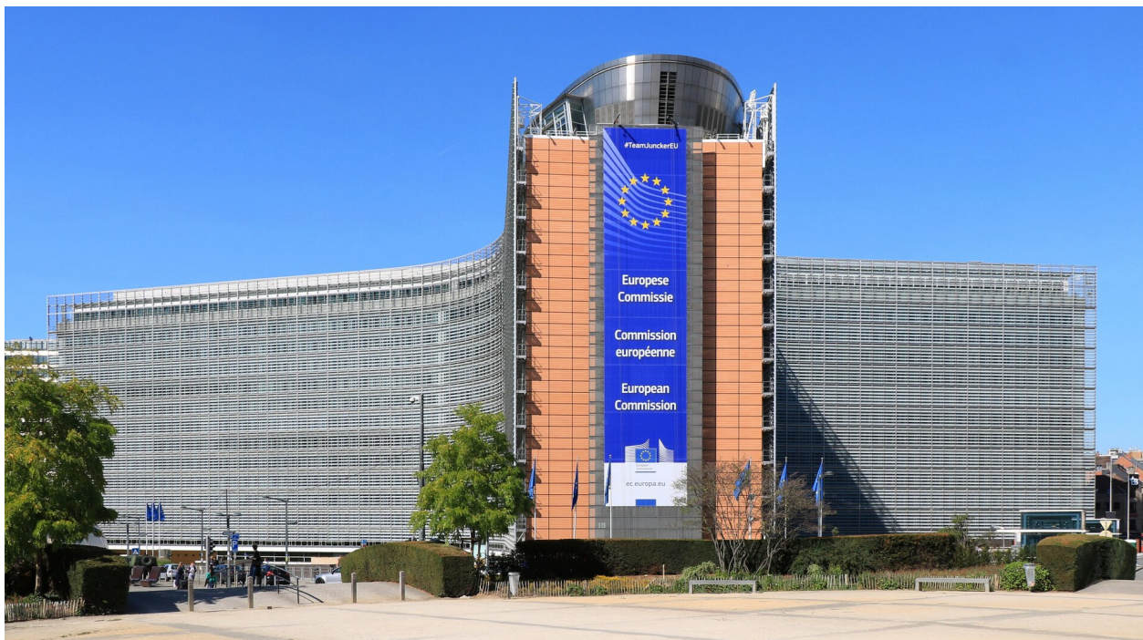
Budynek Berlaymont w Brukseli, siedziba Komisji Europejskiej
