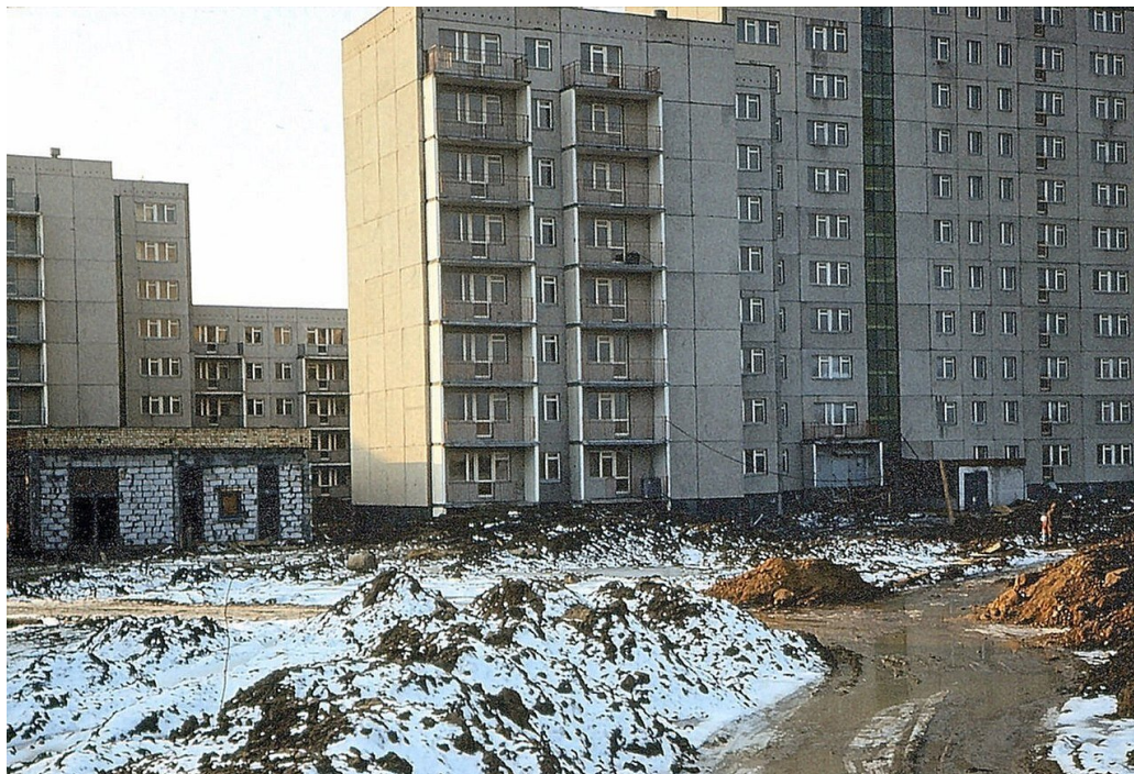
Budowa warszawskiego osiedla Ursynów, 1976/1977
