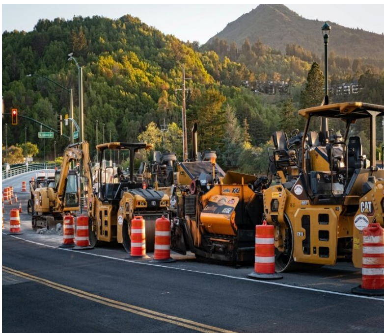
Wykonywanie robót nawierzchniowych
