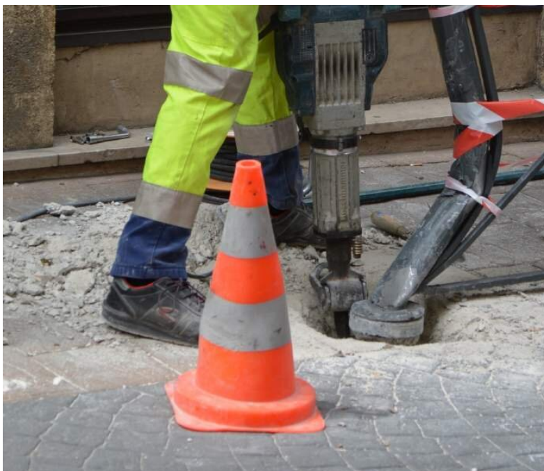
Wykonywanie robót drogowych
