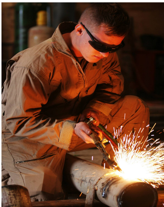
Proces cięcia stalowej rury palnikiem acetylenowo-tlenowym
