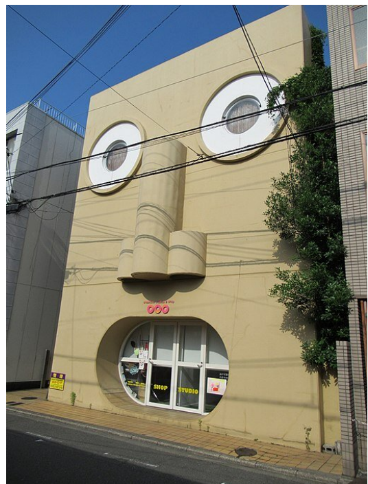
Face House w Nakagyo-ku, Kyoto. Jakie elementy eklektyczne dostrzegasz w tym postmodernistycznym budynku? Źródło: Wikimedia Commons, domena publiczna.
