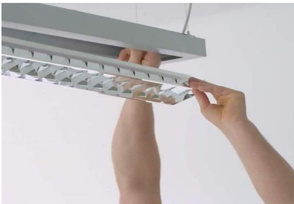
Montaż oprawy oświetleniowej
