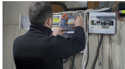
Konserwacja instalacji elektrycznych
