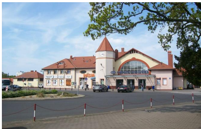
Rysunek 6. Widok na budynek stacji kolejowej Kołobrzeg.
